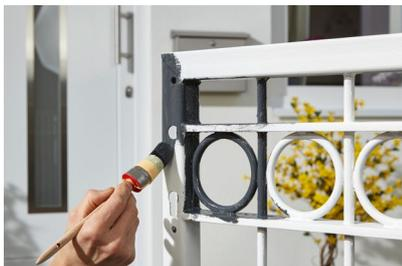
Nun ist die Zinkfläche soweit vorbereitet, dass Sie sie mit Lack streichen können. Dazu den **Alpina Anti-Rost Metallschutz-Lack** flächendeckend auf der gesamten Oberfläche satt auftragen und anschließen für 8 Stunden trocknen lassen.
