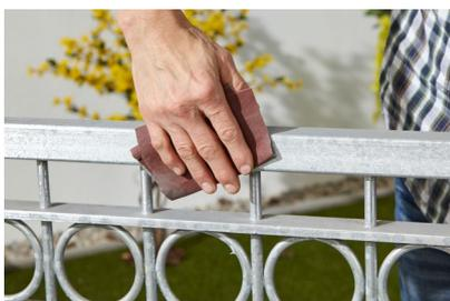
Bevor Sie mit dem Lackieren beginnen, sollten Sie die Umgebung schützen, indem Sie Malervlies auslegen. Nun schleifen Sie das verzinkte Objekt gut an, um die Oberfläche aufzurauen, so wird der nächste Schritt der Netzmittelwäsche noch wirkungsvoller.
