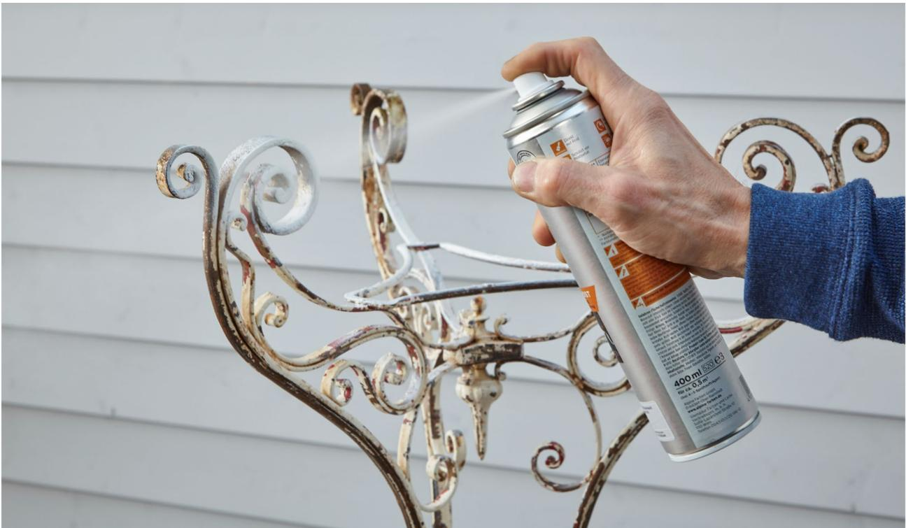
Nachdem Sie die Sprühdose ca. 3 Minuten kräftig aufgeschüttelt haben, können Sie die erste Schicht Metallschutz-Lack mit einem Abstand ca. 25 cm dünn aufsprühen.
