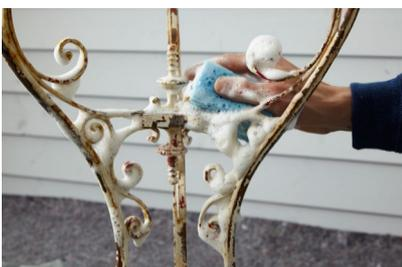
Anschließend waschen Sie etwaige Verschmutzungen zuerst mit Seifenlauge und dann mit klarem Wasser ab. Lassen Sie das Objekt vor dem Lackieren mit dem Sprühlack gut trocknen, denn der **Alpina Anti-Rost Metallschutz-Lack** haftet nur auf trocknen Untergründen.
